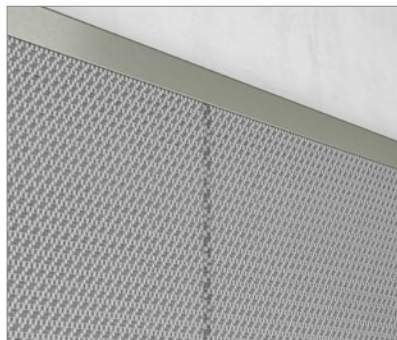
Joints invisibles entre les panneaux et profilés périphériques en aluminium anodisé.
