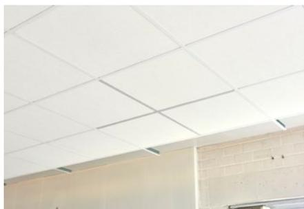
Sur les photos ci-jointes, un plafond réalisé avec le modèle d'ossature Chicago Metallic Matt White 11. Une ossature différente a toutefois été utilisée entre 4 dalles pour la comparaison.
