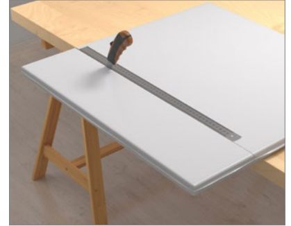
1. Découpez à la dimension nécessaire.
